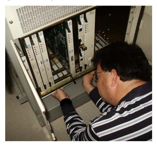
Figure 6-17 Insert fan tray bracket
