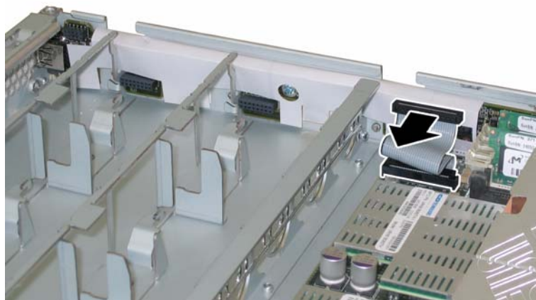
图 3-48 断开前面 I/O 互连线缆
