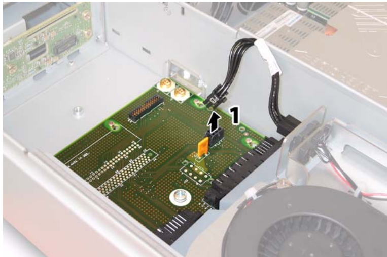
图 4-63 将背面风扇托架从配电板上断开
