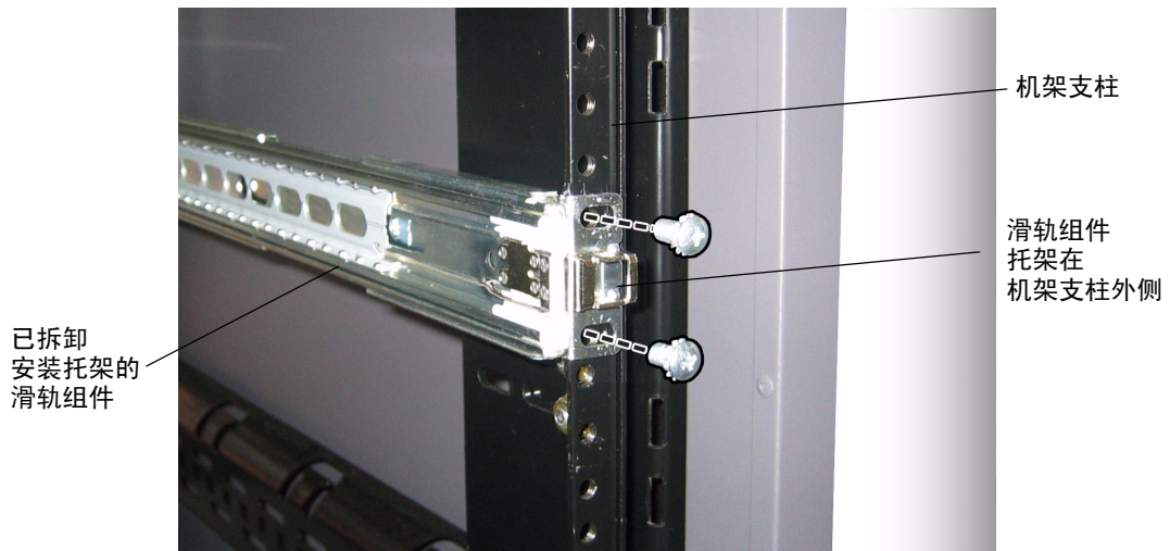
图 1-3 滑轨组件安装在机架支柱上
