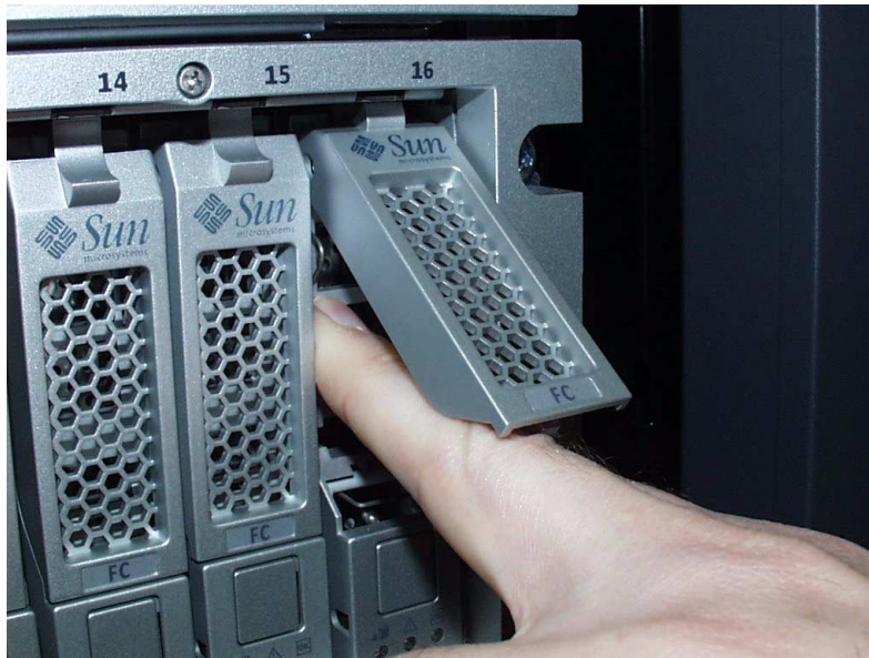
FIGURE A-3 Insertion incorrecte d'un disque dur
